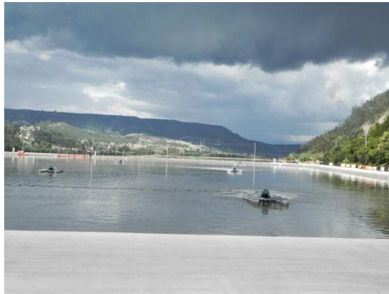
Lagunas de oxidación de la planta de tratamiento de aguas residuales de Cuenca (Ecuador)
